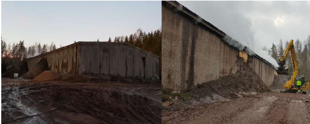
Figur 6. Byggnaden inkapslad med sprutbetong till vänster och vägen som fick byggas till höger. Foto: Räddningstjänsten Östra Skaraborg.
