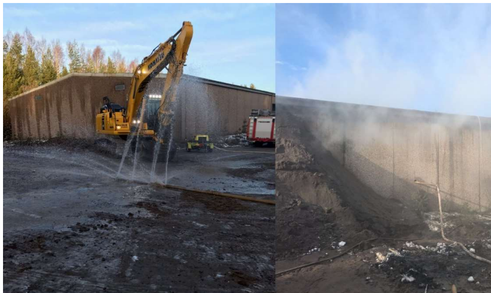
Figur 5. De egentillverkade vattenspetten. Foto: Räddningstjänsten Östra Skaraborg.
