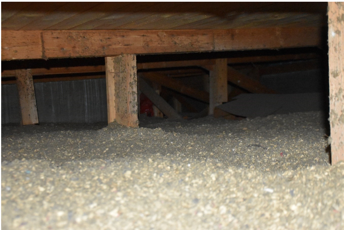
Figur 3. Lösullsisolering på vinden.
