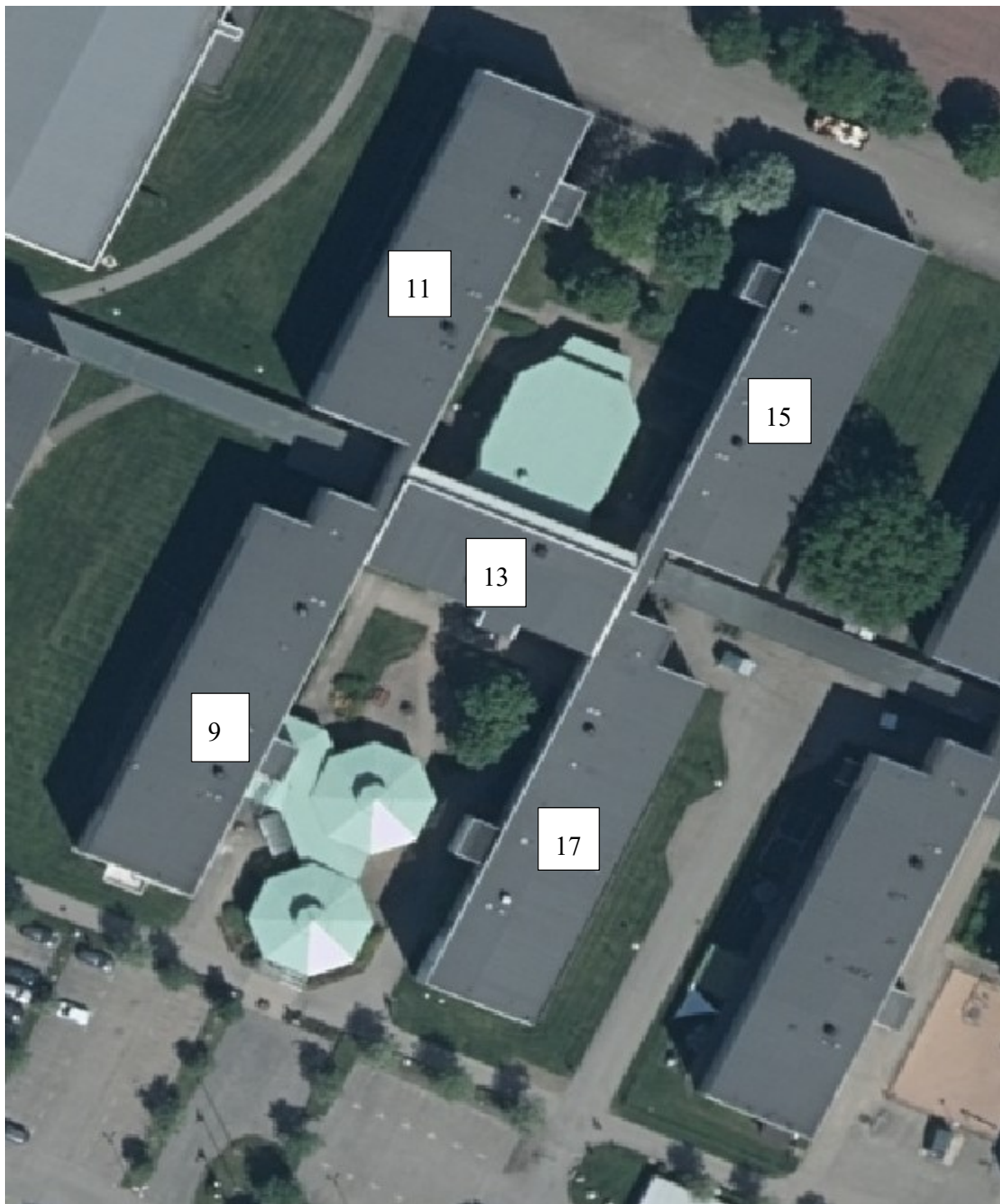
Figur 1. Översiktsbild av byggnadskomplex som varit direkt berört av branden
