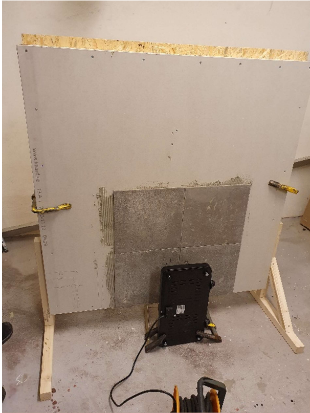
Figur 13. Prototyp av väggkonstruktionen i den brandutsatta byggnaden.
