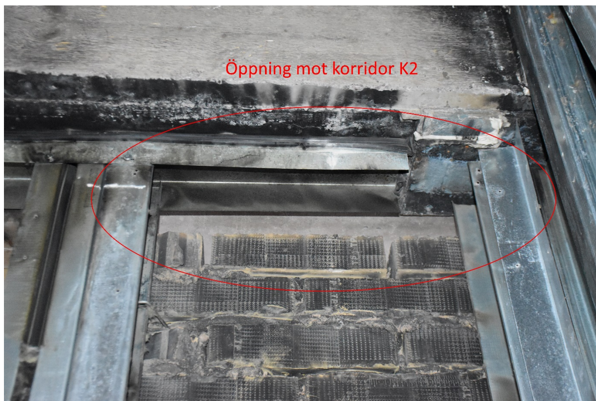
Figur 40. Bild som visar öppningen mot korridor K2, bild tagen inifrån lägenheten
