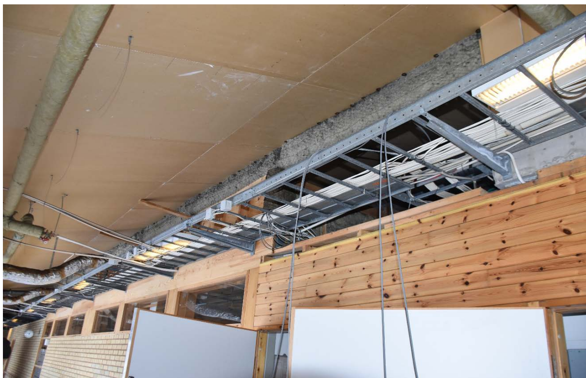
Figur 26. Vägg mellan rehabavdelning och korridor K4, nedpendlat undertak är bortplockat.
