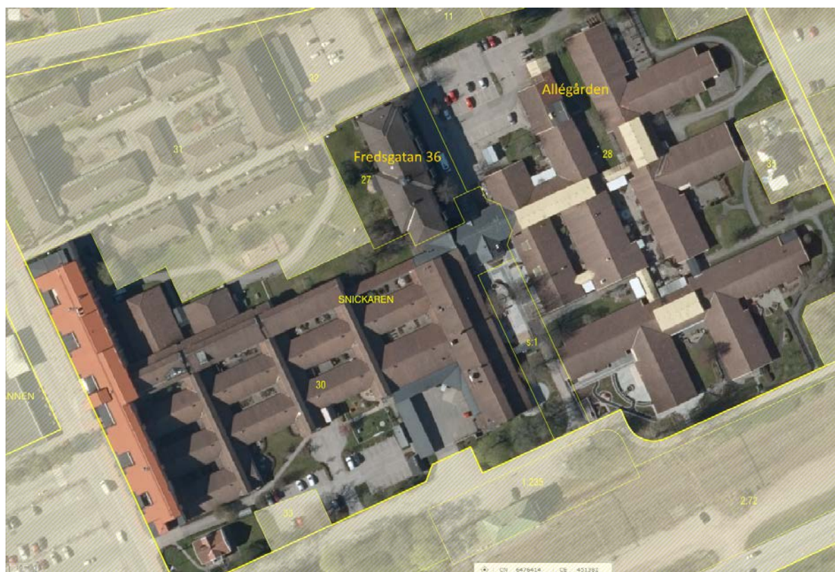
Figur 1. Hela byggnadskomplexet med fastighetsbeteckningar.
