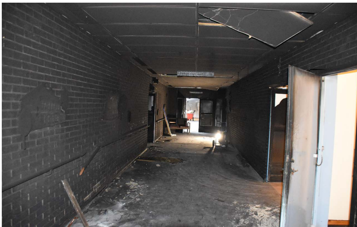
Figur 20. Foto som visar korridor K2, dörr i korridorens slut är branddörr mot förbindelsegång till korttiden.
