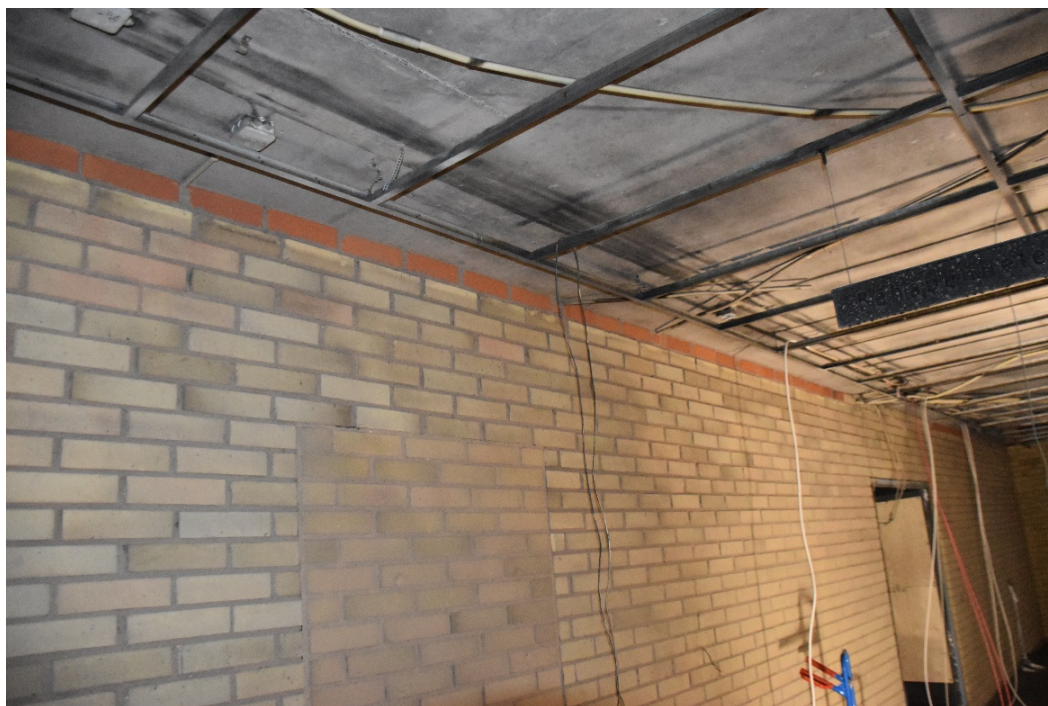
Figur 42. Delar av brandcellsgräns i korridor K2, som murats mot betongplatta
